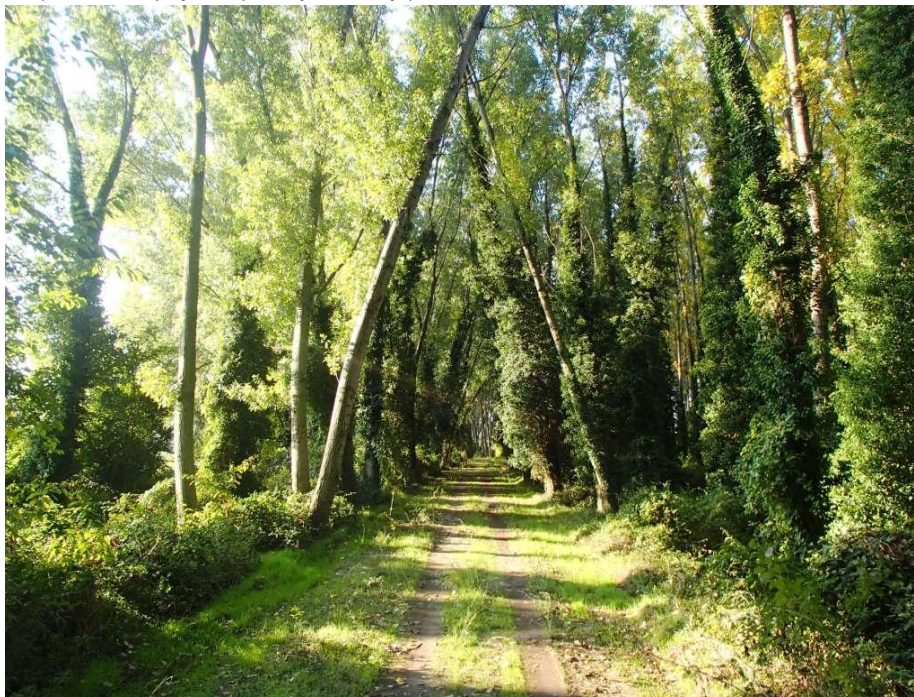
Εικόνα 7.2. Ανατολικό ανάχωμα ποταμού Νέστου.
